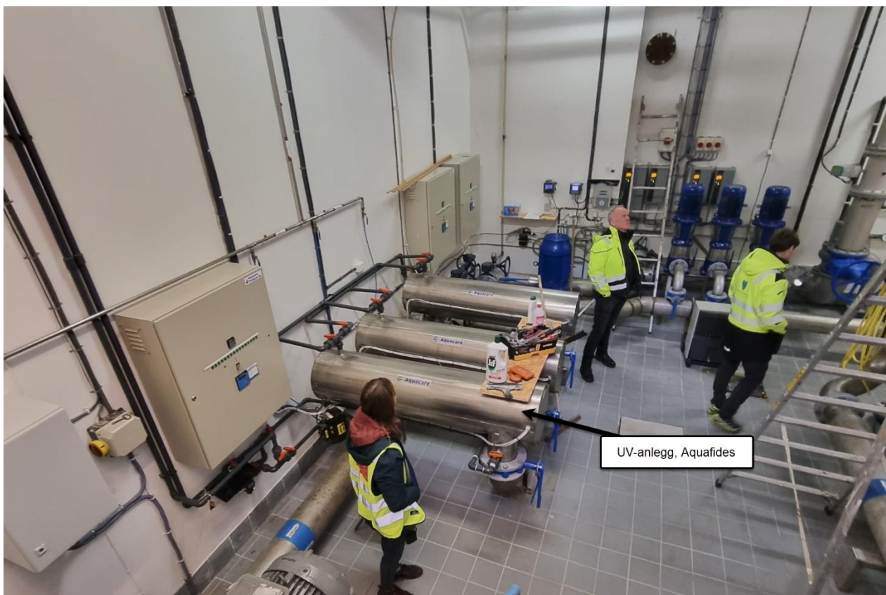
Figur 12: Bilde viser dagens 3 UV-filtre, som håndterer ca. 120 m 3 hver.
