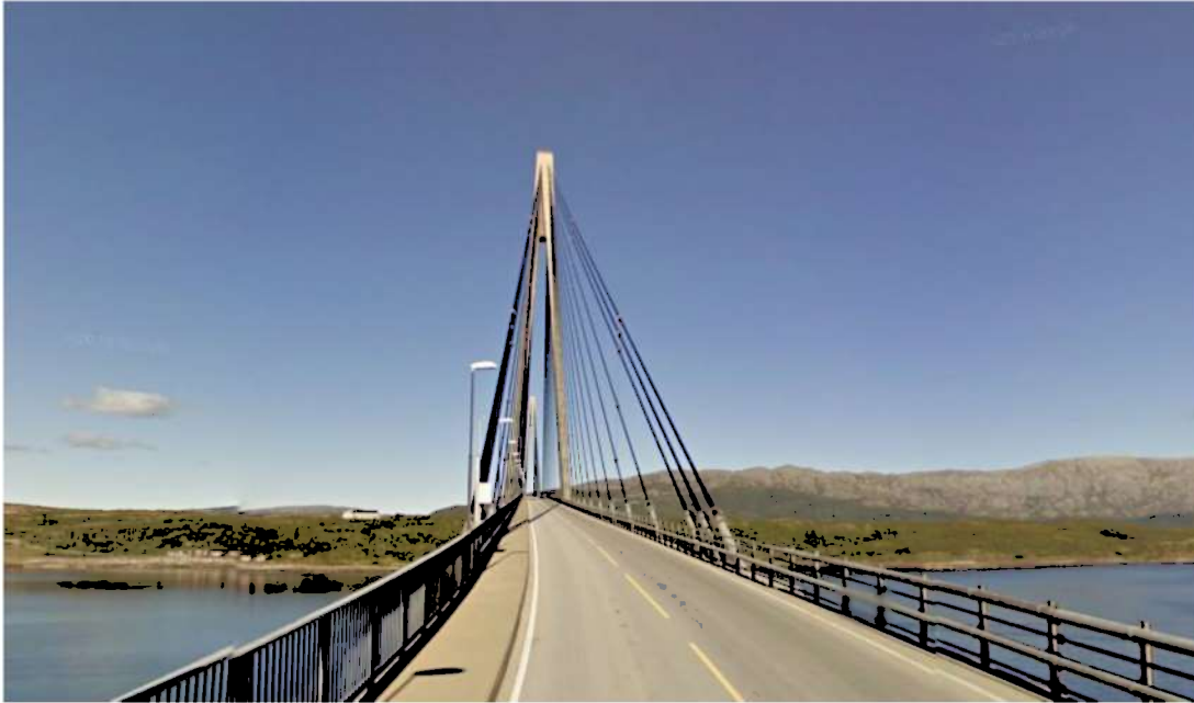
Figur 4-27: Helgelandsbrua (foto: Google Maps)
