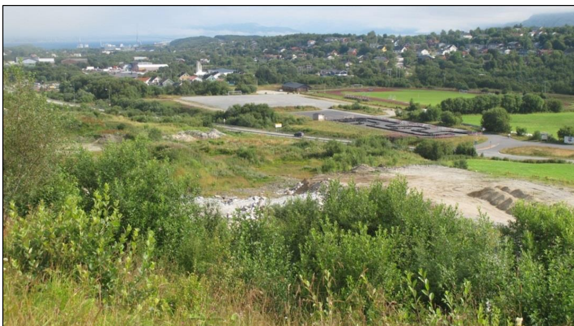
Figur 9 – Sør­lige deler av planområdet består for det meste av en fylling. Foto Oddmund Wold
