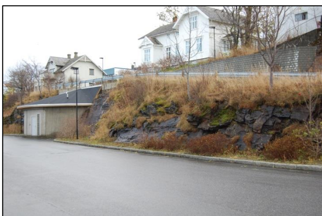
Figur 14. Johan B. Jacobsens gate oppover i bolig-områdene med fjellskjæringen og kommunal-teknisk anlegg/pumpestasjon i skjæringen langs Havnegata.
