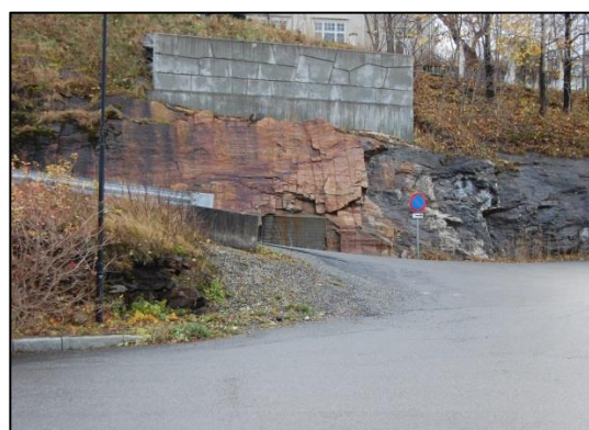
Figur 12. Skjæringen mot sør, og bebyggelsen i bakkant av denne
