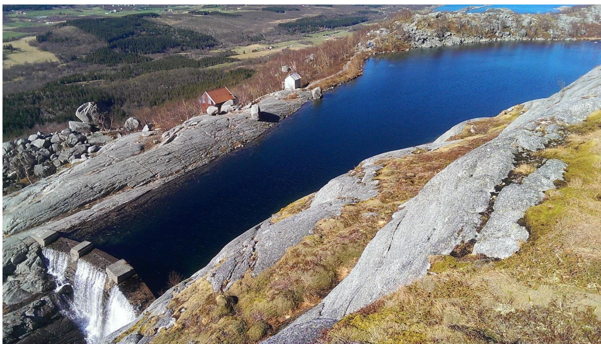
FIELLSÅSDEMNINGEN, DEL AV DEN TIDLIGERE VANNFORSYNINGEN TIL SANDNESSJØEN. FOTOGRAF: TROND BARGEL.
