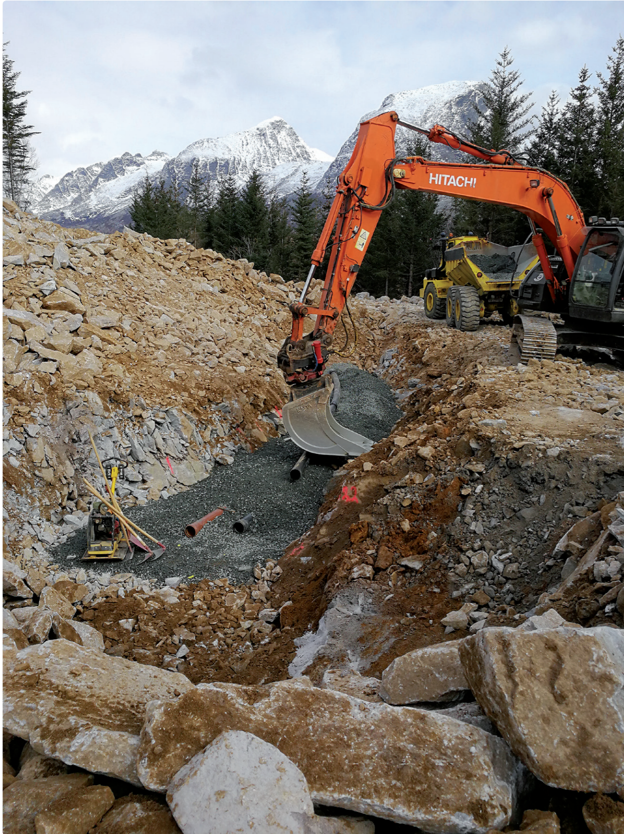
Etablering av vei/infrastruktur på Ringveien på Søvikmoen.
