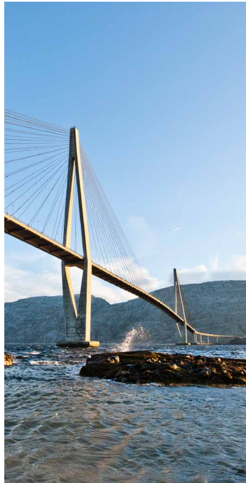
Kommunikasjon. Helgelandsbrua ble kåret til Norges vakreste i 2010. Den er dessuten viktig for å knytte Helgelandskysten sammen.
